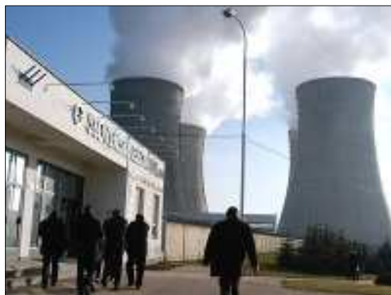
Torres refrigeradoras de una central térmica emitiendo gran cantidad de \text{CO}_2
