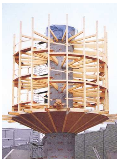
->Grundgerüst des Heliotrops mit Wendeltreppe
